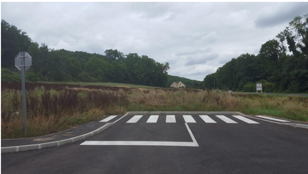
Les premiers pavillons à l'Est du site (avec attente de voirie au premier plan)
