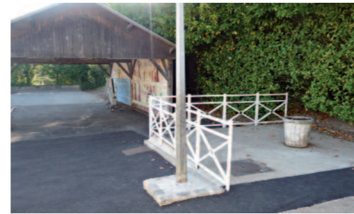
Des travaux de rénovation de la cour de l'école élémentaire
