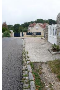
RÉFECTION PARTIELLE D'UN BAS CÔTÉ RUE JOURDAIN 3 960 € TTC
