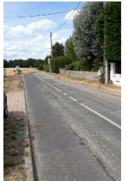
CRÉATION D'UNE CANALISATION POUR LES EAUX DE PLUIE ROUTE DE BLANCHEFACE 2 800 € TTC
