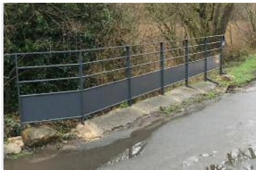
INSTALLATION D'UN GARDE-CORPS PONT DE LA RACHÉE 4 200 € TTC
