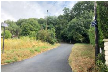
RÉFECTION DE LA VOIRIE DE LA BEAUÇONNERIE 8 100 € TTC
