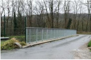
CHANGEMENT DE GARDE-CORPS SUR LE PONT DE LA SNCF EN MONTANT À LA ROUTE DU TERTRE
