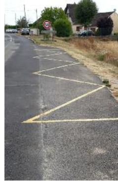
ELARGISSEMENT DE LA VOIRIE POUR ARRÊT DE BUS ROUTE D'ÉTAMPES À BLANCHEFACE REMISE À NIVEAU DES BOUCHES D'ÉGOUT 3 440 € TTC
