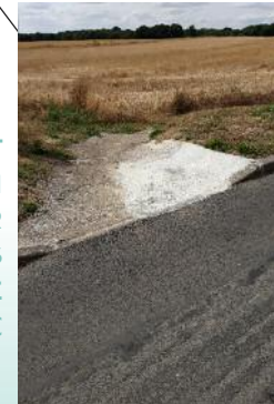
ELARGISSEMENT ET SÉCURISATION DE L'AVALOIR ROUTE D'ÉTAMPES À BLANCHEFACE 3 694 € TTC
