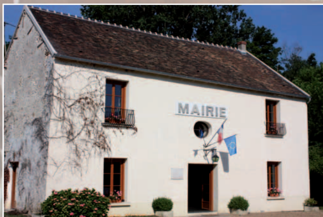
Réfection de la toiture de la salle des mariages.
